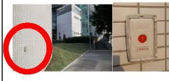
多功能活動中心輔樓後側
