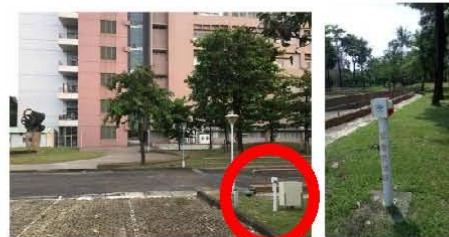
第二實習大樓後方停車場
